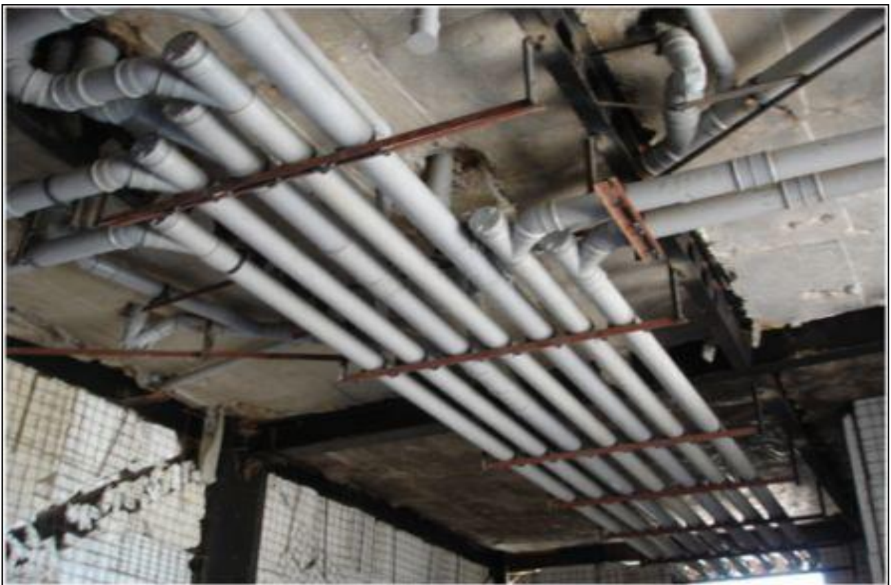
نصب لوله بصورت افقی
